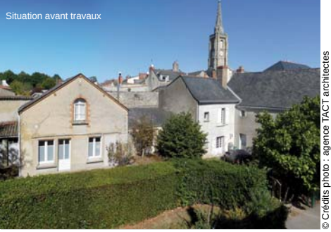
Situation avant travaux
