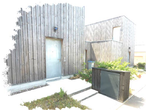
Intégration des éléments techniques
